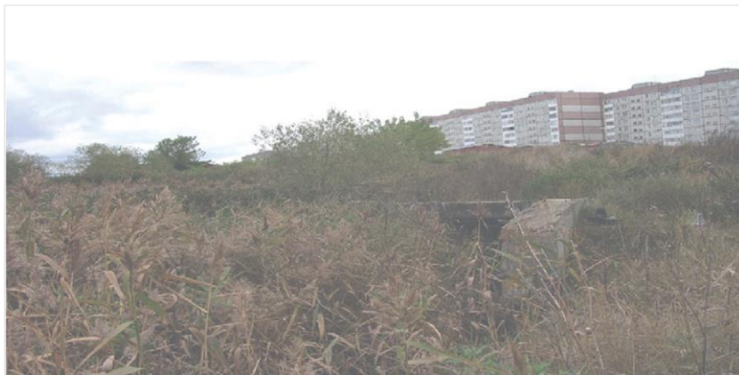
Фото 4. Выход городской ливневой канализации №3.
